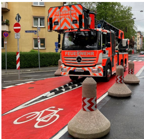
Einsatzfahrzeuge können ohne größere Verzögerung die Diagonalsperre passieren
