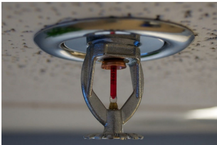
Abbildung 8: Sprinklerkopf mit roter Ampulle (Auslösetemperatur 68° C) [5]
